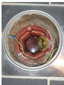
Tettesjiktets tilslutning til sluk - Sluk
