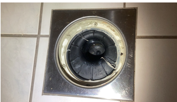
Kontroll av sluk.
