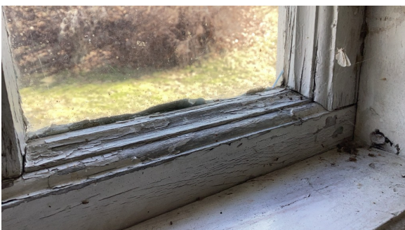
Sprekk i glass.
