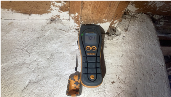
Ved enkle fuktmålinger registrerte jeg tørre verdier.
