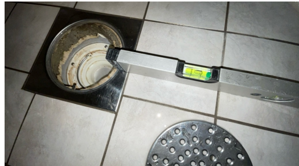
Fallforhold målt i retning sluk.
