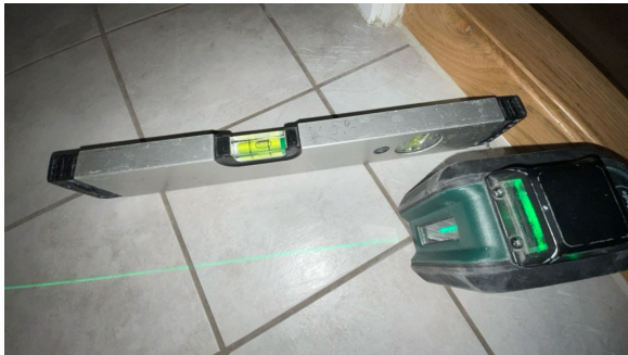
Fallforhold målt i retning sluk.
