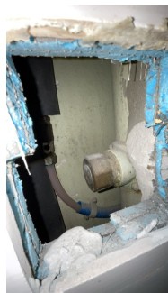
Original støpejernsrør (avløpsrør).
