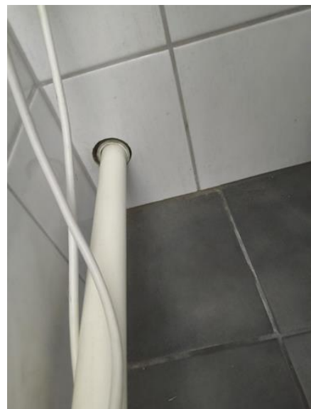
Overflater vegger - [Rørgjennomføring tilknyttet toalett ]
