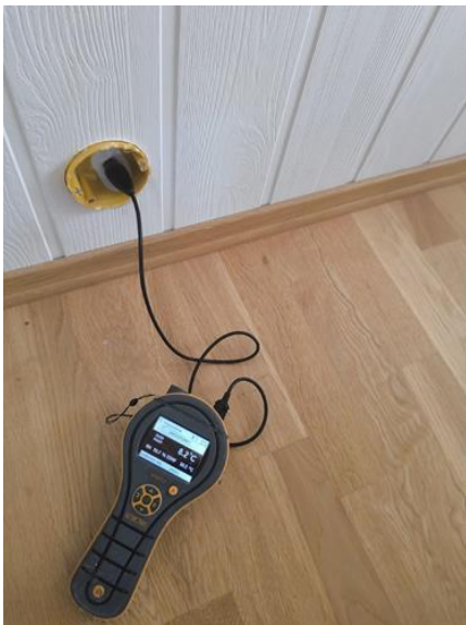
Fukt i tilliggende konstruksjoner - [Fuktmåling ]
