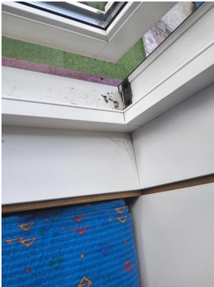
Dører og vinduer - [Vindu på hems ]
