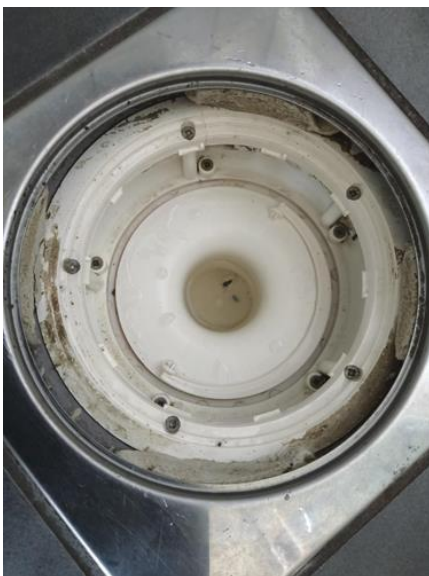
Slukets tilkomstmulighet for rengjøring - [Sluket i dusjonen ]
