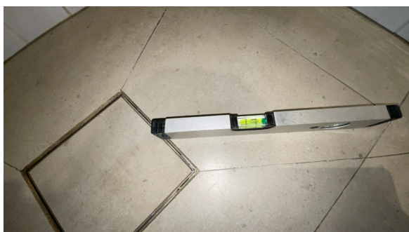
Fallforhold målt i retning sluk.
