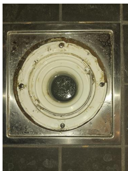
Tettesjiktets tilslutning til sluk - Sluk bad
