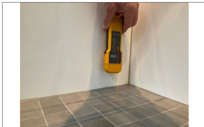
Kontroll av fall på gulv bad.
