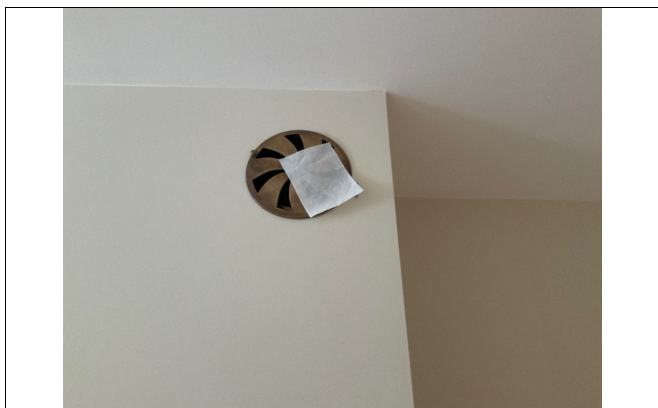
Kontroll av avtrekk på garderøberom.
