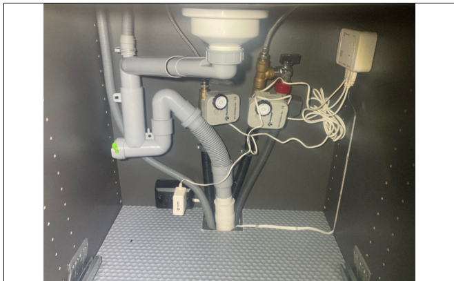
Kontroll av røropplegg i kjøkkenbenk.
