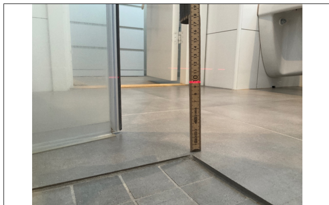
Kontroll av fall på gulv bad.
