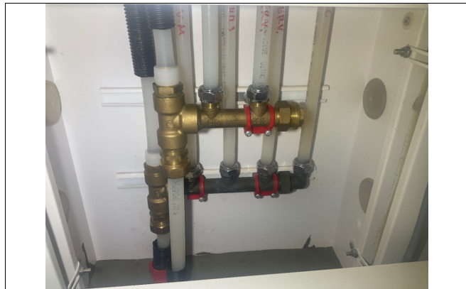
Kontroll av rørskap.
