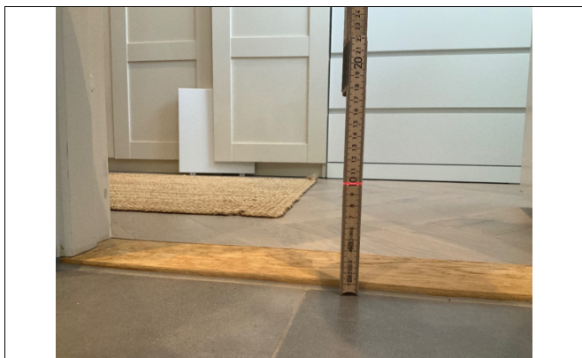
Kontroll av fall på gulv bad.
