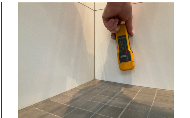
Kontroll av fall på gulv bad.
