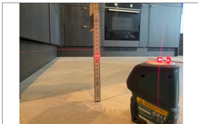
Nivellering av gulv.
