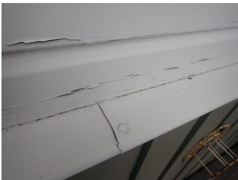
Kledning er stedvis oppsprukket på nedre del mot terreng
