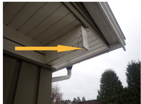
Takbjelker er ført ut over fasadevegg,
