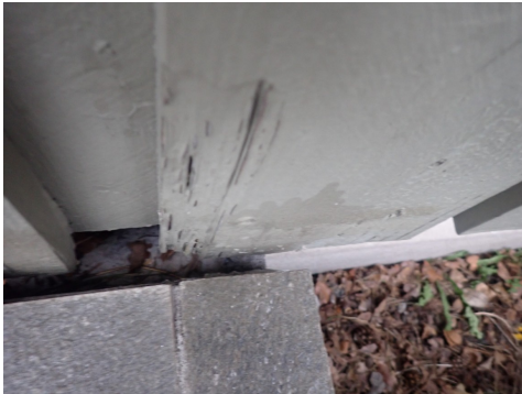
Kledning er stedvis oppsprukket på nedre del mot terreng
