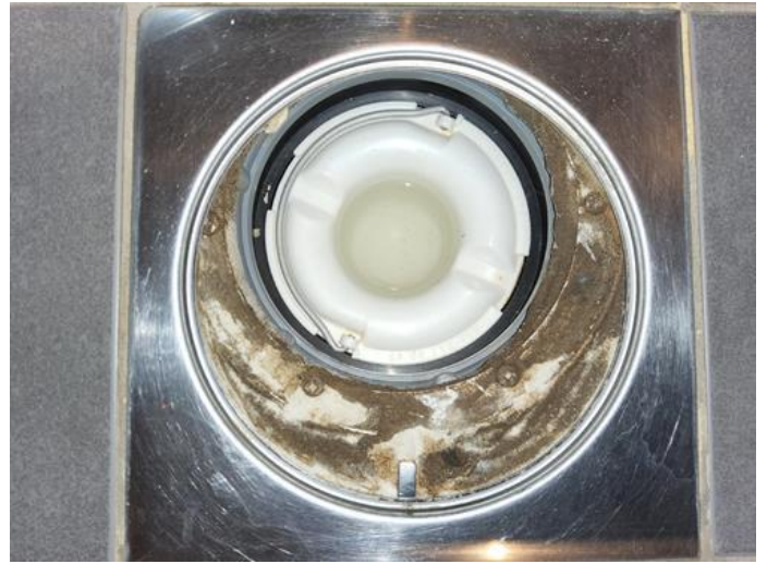
Membran, tettesjikt og overgang til sluk. - [Sluk på badetrom i 1.etasje ]
