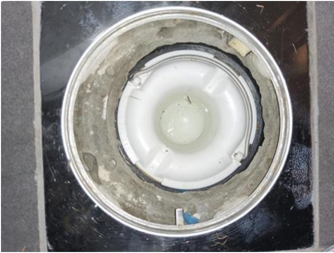
Membran, tettesjikt og overgang til sluk. - [Sluk på vaskerom ]
