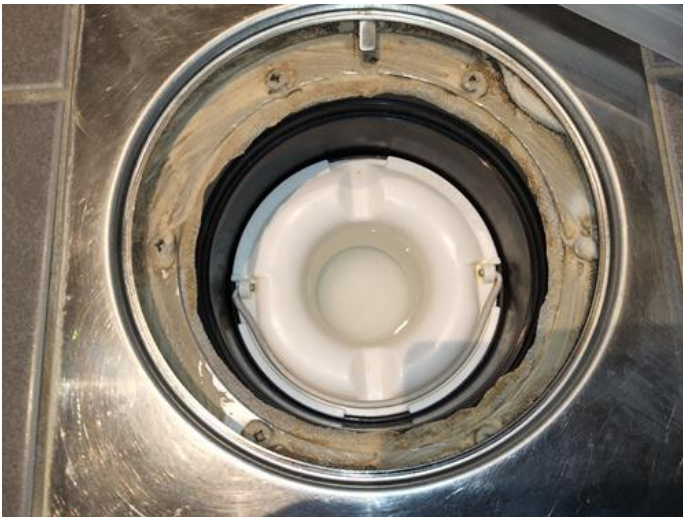
Membran, tettesjikt og overgang til sluk. - [Sluk på badetrom i 2.etasje ]
