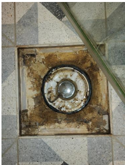
Tettesjiktets tilslutning til sluk - Sluk Baderom Loftsetasje.
