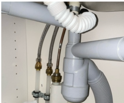
Rørøpplagg på kjøkken.
