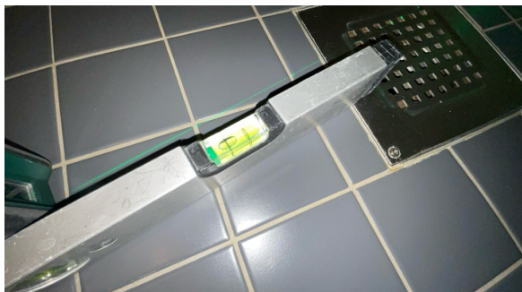
Fallforhold målt i retning sluk.
