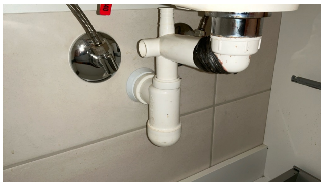
Utett avløpsrør
