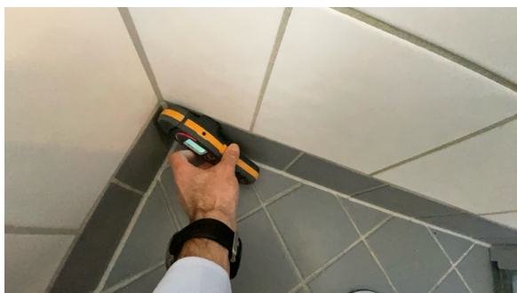
Fuktsøk med Protimeter fuktapparat.
