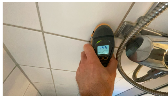
Fuktsøk med Protimeter fuktapparat.
