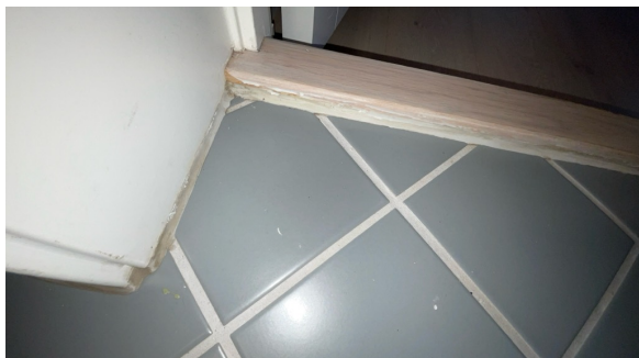
Overgang ved dørterskel.
