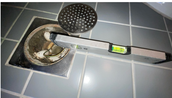
Fallforhold målt i retning sluk.
