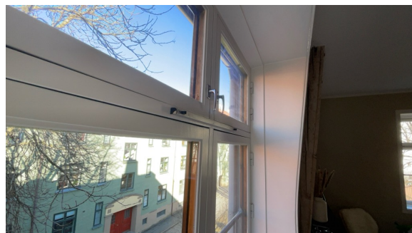
Luftespalte over vinduer.
