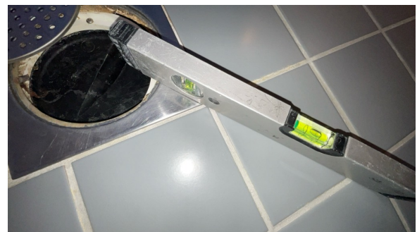
Fallforhold målt i retning sluk.
