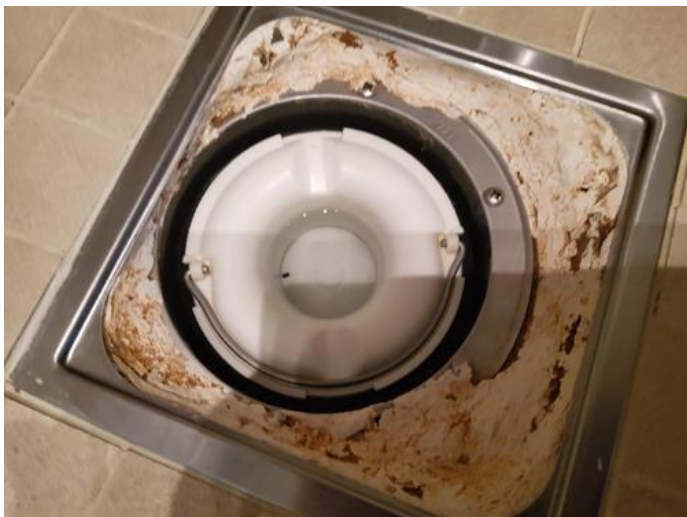
Membran, tettesjikt og overgang til sluk. - [Sluk badrom 1]
