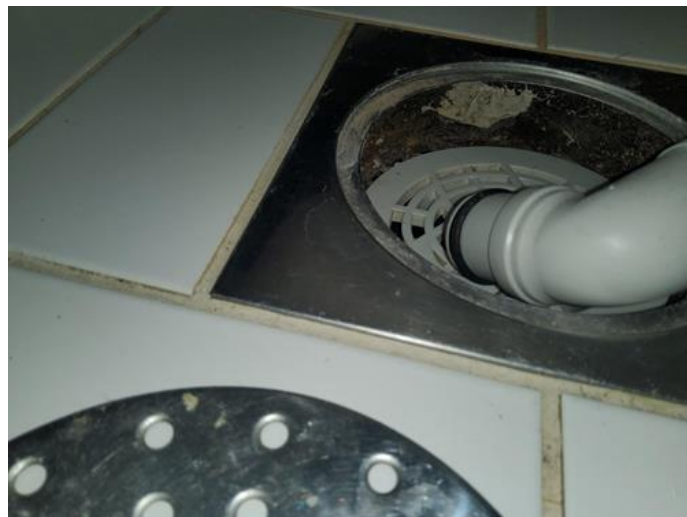
Membran, tettesjikt og overgang til sluk. - [Sluk baderom 2]
