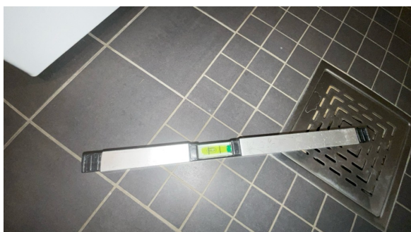
Fallforhold målt i retning sluk.
