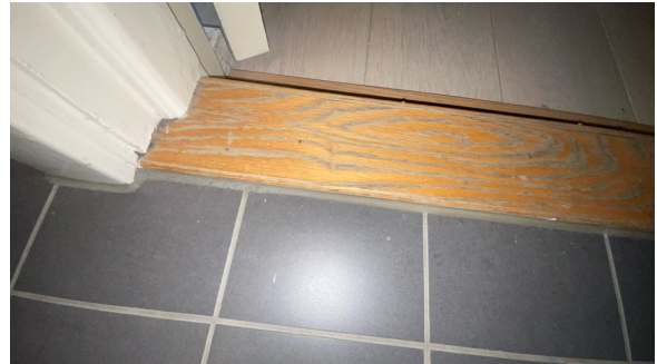
Overgang ved dørterskel.
