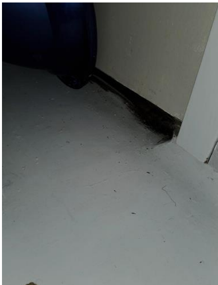
Membran, tettesjikt og overgang til sluk. - [Spalte mot baderom. ]
