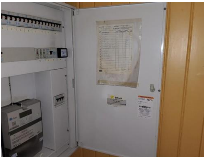
Elektrisk anlegg - [Kursfortegnelse.]
