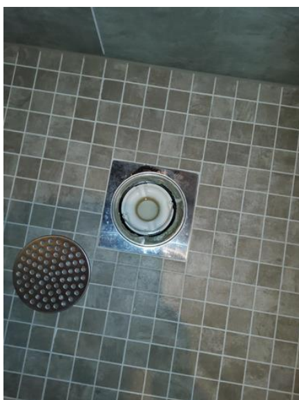
Membran, tettesjikt og overgang til sluk. - [Sluk Baderom 2.etasje.]
