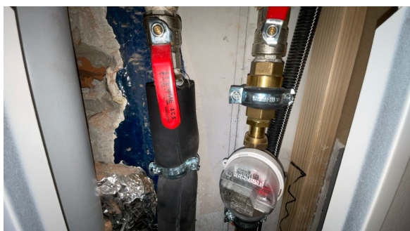
Inspeksjonsluke på ett soverom (tidligere kjøkken).
