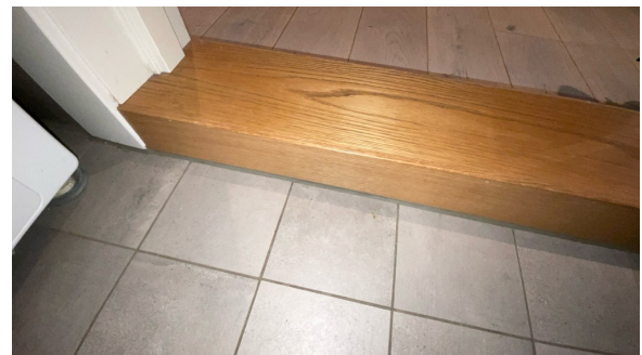
Overgang ved dørterskel.
