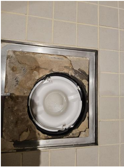
Membran, tettesjikt og overgang til sluk. - [Sluk]
