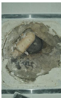
Tettesjiktets tilslutning til sluk - Sluk bad
