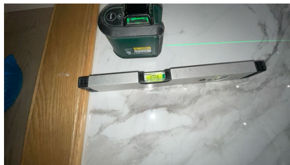
Fallforhold målt i retning sluk.
