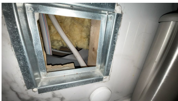
Inspeksjonsluke til høyre for toalettet.
