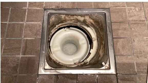
Kontroll av sluk.
