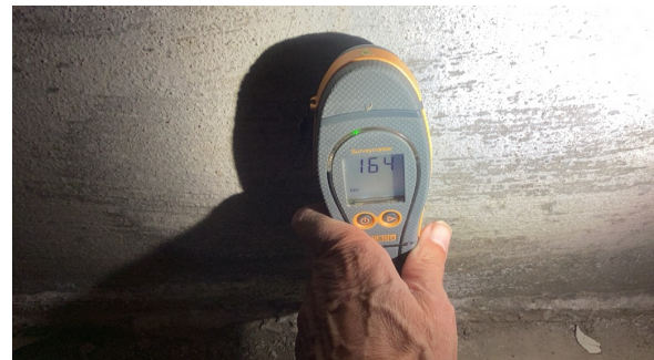
Kjellervegg. Ved enkle fuktsøk ble det ikke registrert unormale verdier.
