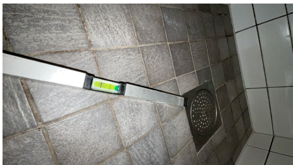
Fallforhold målt i retning sluk.
