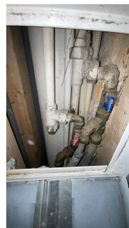
Både originale rør og nyere plastrør innenfor inspeksjonsluken.
