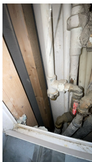
Avløpsrør (hvitt, stort rør i bakkant på bildet).
