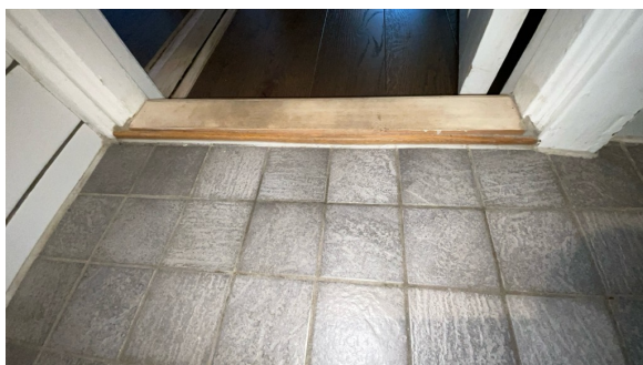
Overgang ved dørterskel.
