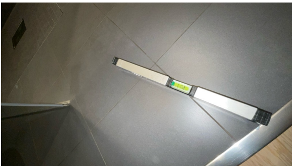
Fallforhold målt i retning sluk.
