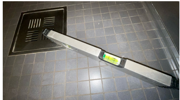
Fallforhold målt i retning sluk.
