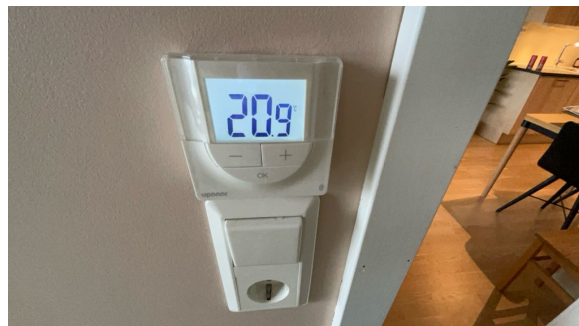
Regulator for vannbåren gulvvarme.
