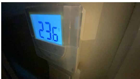
Regulator for vannbåren gulvvarme.
