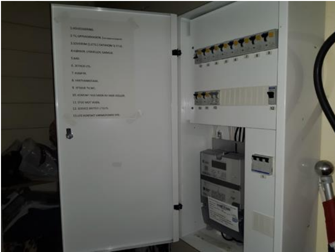
Beskrivelse - [Sikringsskap]
