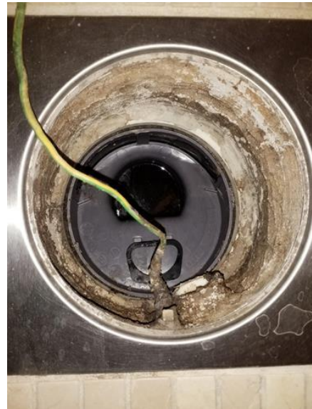
Membran, tettesjikt og overgang til sluk. - [Sluk bad kjeller ]
