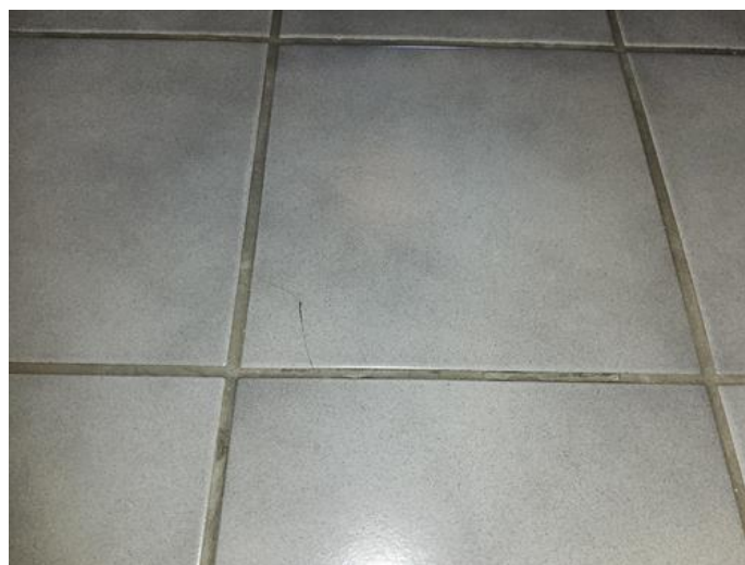
Overflater gulv - [Gulvflis vaskerom]
