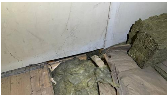
Branntekniske vurderinger - [Brannskille ved loft]
