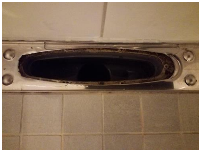
Membran, tettesjikt og overgang til sluk. - [Sluk dusjsonen i baderom/vaskerom i 1 etasje. ]
