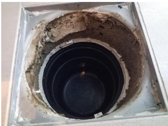
Membran, tettesjikt og overgang til sluk. - [Sluk i badrom i 2 etasje. ]
