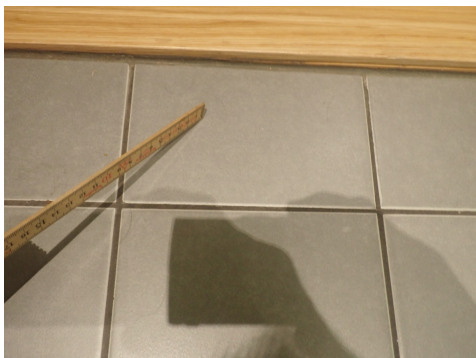
Det er påvist "bom" hulromslyd på flere fliser på hovedgulv.
