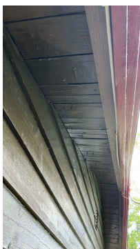
Spiker kommer gjennom panel i gavlautstikk
