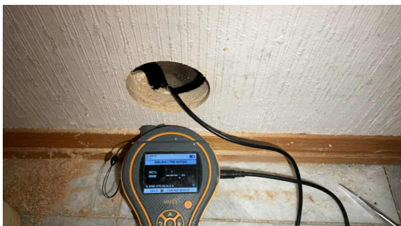
Ved fuktmåling ble det registrert tørre verdier.
