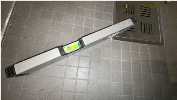
Fallforhold målt i retning sluk.
