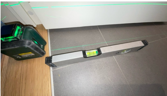
Fallforhold målt i retning sluk.
