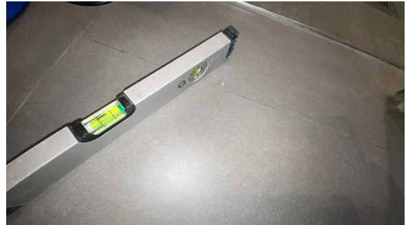
Fallforhold målt i retning sluk.
