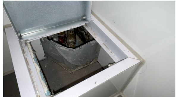
Rørkoblinger synlig gjennom inspeksjonsluke i gulv til høyre for toalettet.
