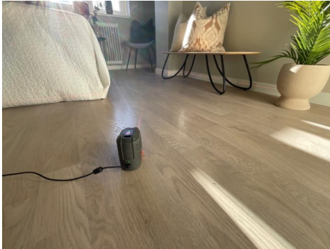
Nivellering soverom, ingen avvik registrert
