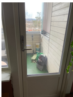
Balkongdør med malt treramme
