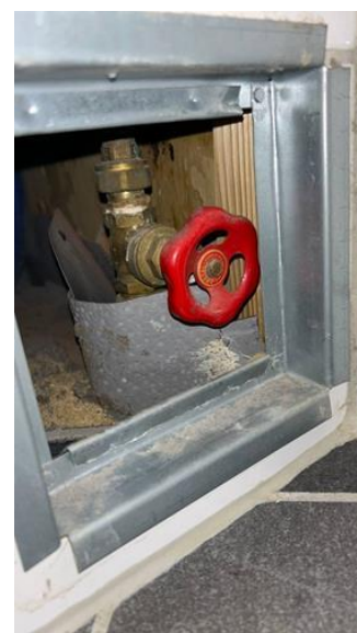
Tekniske anlegg, VVS anlegg (Sjekkpunkter utover det som er inkludert i andre rom) - [Hovedstoppekran]
