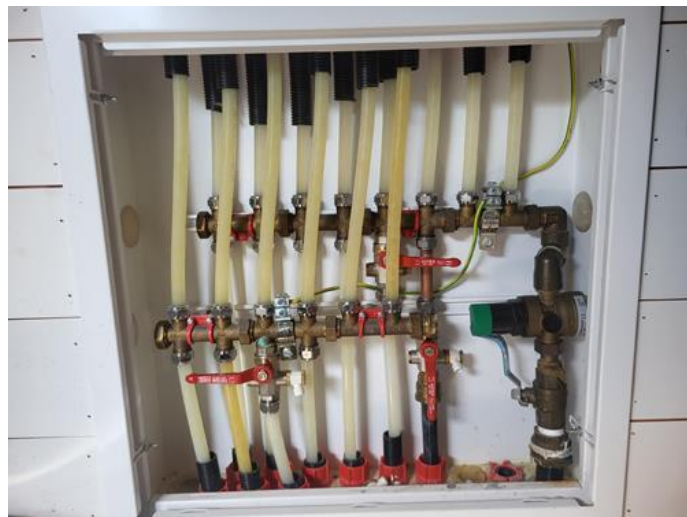
Tekniske anlegg, VVS anlegg (Sjekkpunkter utover det som er inkludert i andre rom) - [Koblingskap for vannrør og stoppekraner]
