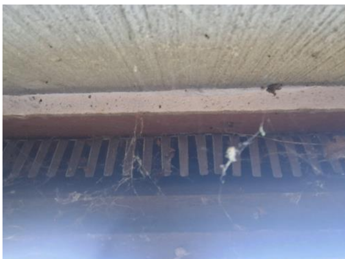
Yttervegger inkl. fasader og konstruksjon - [Musebånd bak]
