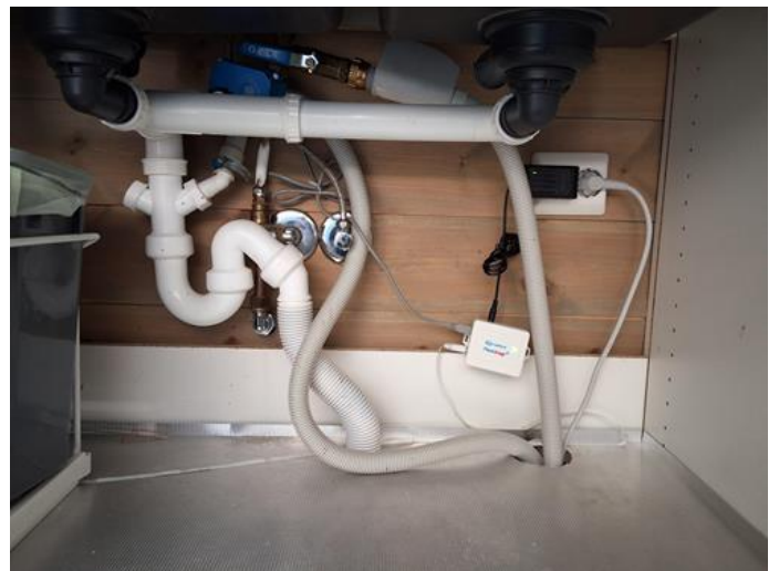
Kjøkken - [Røropplegg kjøkken benk]
