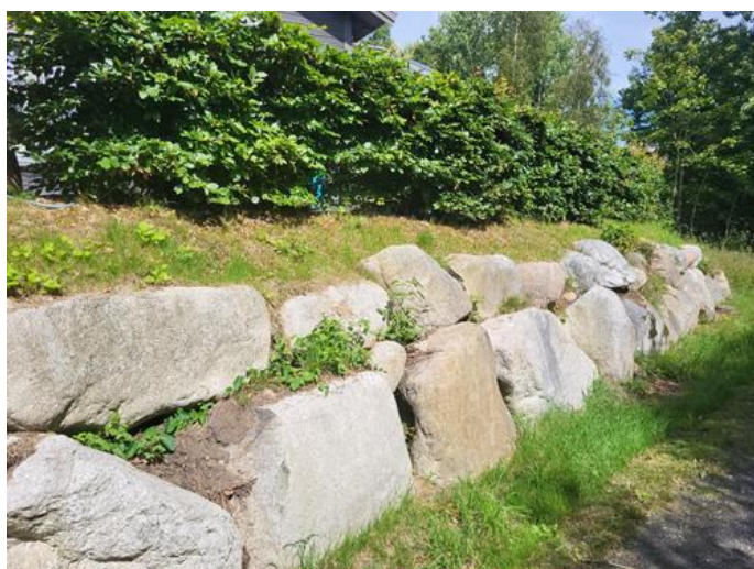
Utvendig - [Støttemur av naturstein]
