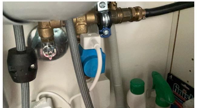
Automatisk lekkasjesikring i kjøkkenskap
