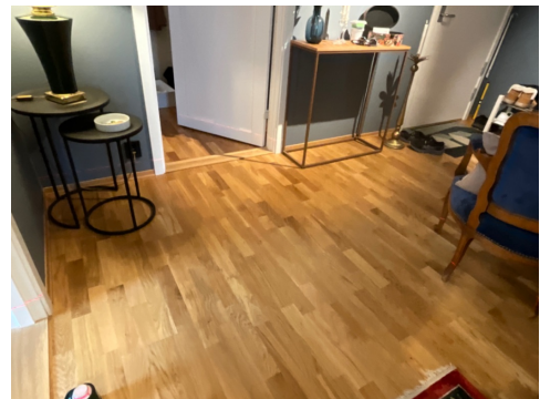
Kontroll av høydeavvik
