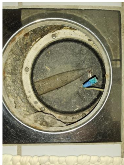
Tettesjiktets tilslutning til sluk - Hjelpesluk bad
