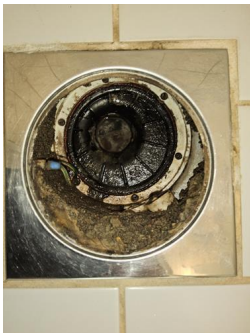
Tettesjiktets tilslutning til sluk - Hovedsluk bad
