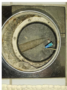
Tettesjiktets tilslutning til sluk - Hjelpesluk bad
