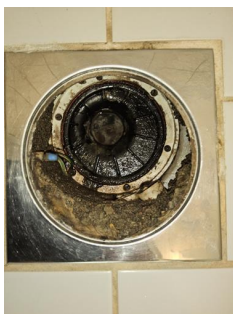
Tettesjiktets tilslutning til sluk - Hovedsluk bad
