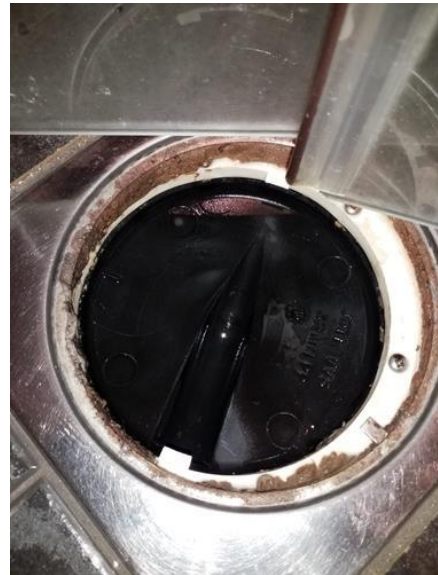
Membran, tettesjikt og overgang til sluk. - [Sluk dusj]
