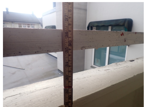
Rekkverk er 92 cm høyt
