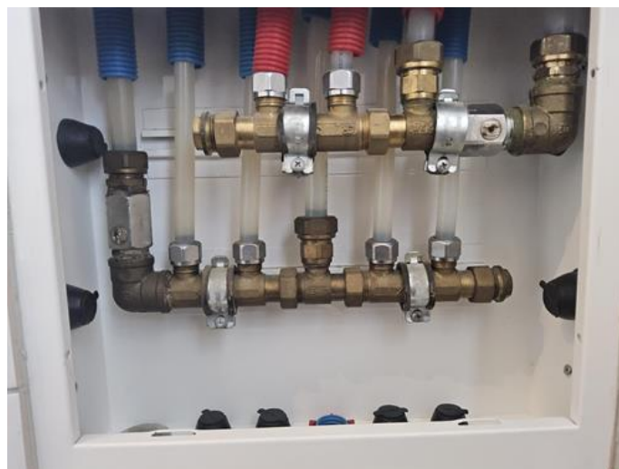
Vannrør - [Fordelerskap for rør-i-rør]
