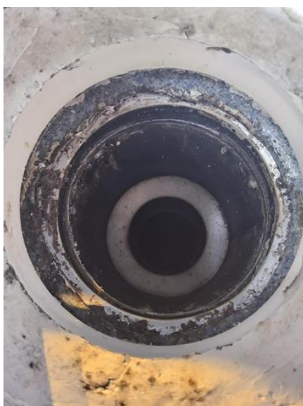
Membran, tettesjikt og overgang til sluk. - [Sluk]
