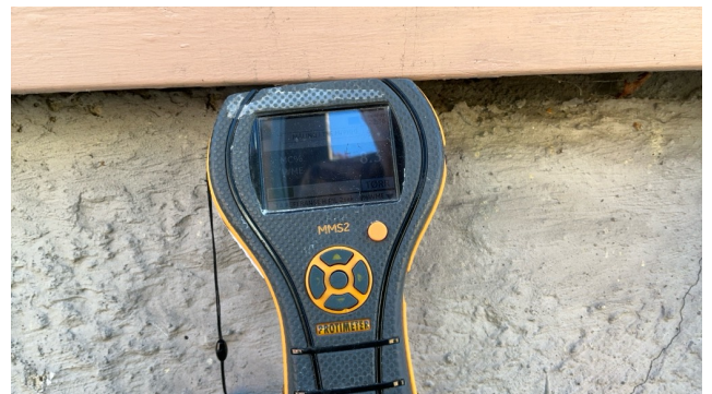
Stikktaking fuktkontroll panel. Det ble ikke registrert avvik.
