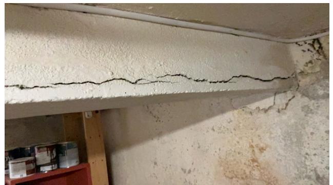
Sprekk bjelke
