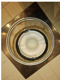
Tettesjiktets tilslutning til sluk - Sluk bad
