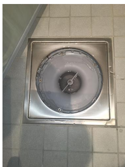
Tettesjiktets tilslutning til sluk - Sluk bad
