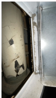
Avløpsrør synlig innenfor inspeksjonsluke.
