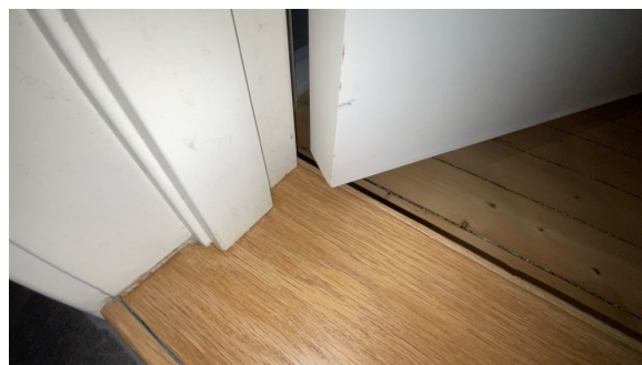
Luftespalte under dørbladet.
