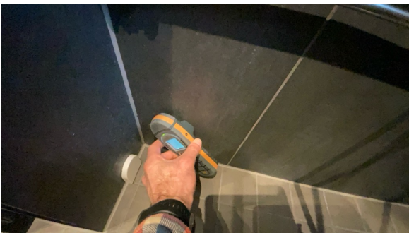
Protimeter fuktapparat gjorde ingen unormale utslag ved fuktsøk i dusj.
