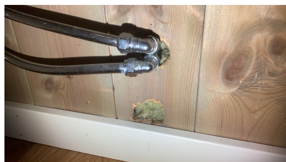
Rørgjennomføring i vegg.
