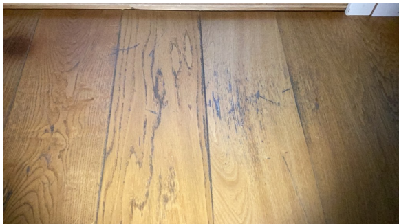
Fuktskade.
