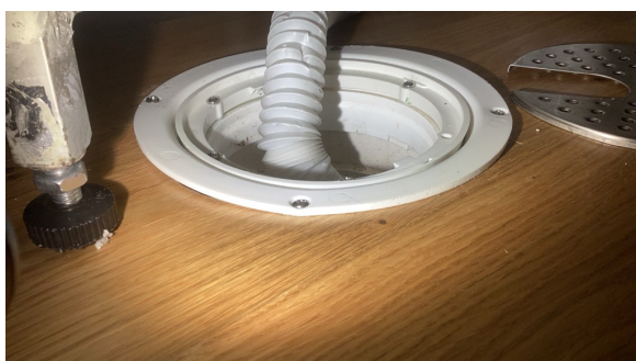
Kontroll av sluk.
