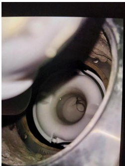
Tettesjiktets tilslutning til sluk - Sluk under badekar
