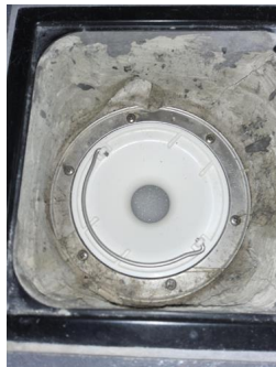
Tettesjiktets tilslutning til sluk - Sluk under servant
