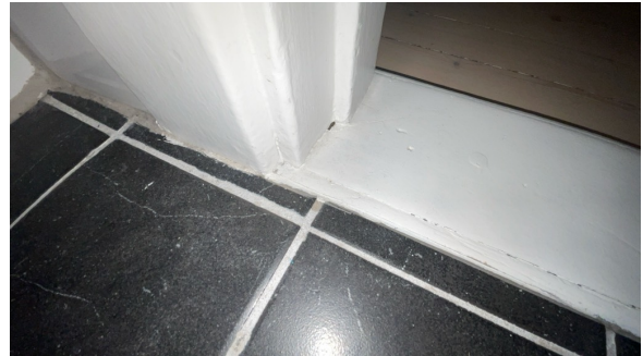
Overgang ved dørterskel.
