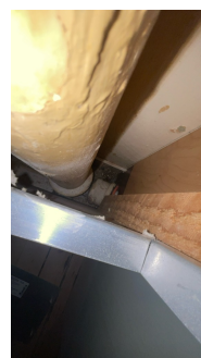
Originalt avløpsrør på kjøkken, synlig innenfor inspeksjonsluke.
