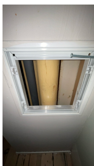
Originalt avløpsrør på kjøkken, synlig innenfor inspeksjonsluke.
